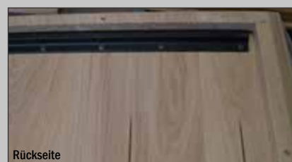
Stahlprofil & Entlastungsrillen
