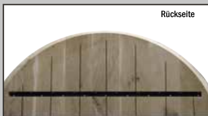
Stahlprofil & Entlastungsrille
