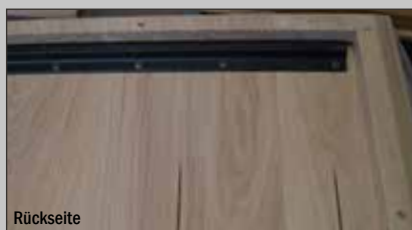
Stahlprofil & Entlastungsrillen
